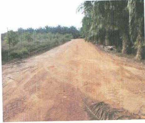
โครงการซ่อมแซมถนนลูกรังสาย ท.๓๑๔
