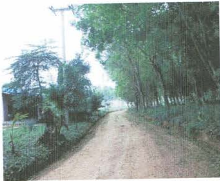
โครงการซ่อมแซมถนนลูกรังสาย ท.๖๐๓
