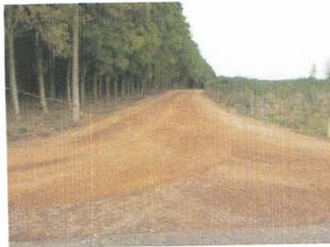
โครงการซ่อมแซมถนนลูกรังสาย ท.๖๑๓
