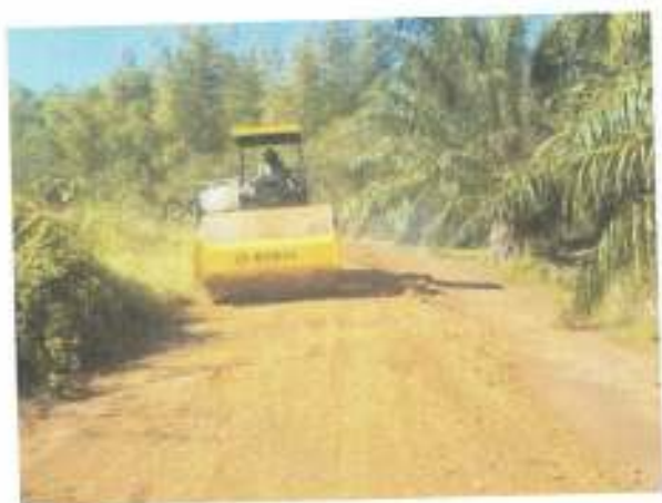
โครงการซ่อมแซมถนนลูกรังสาย ท.๓๐๖
