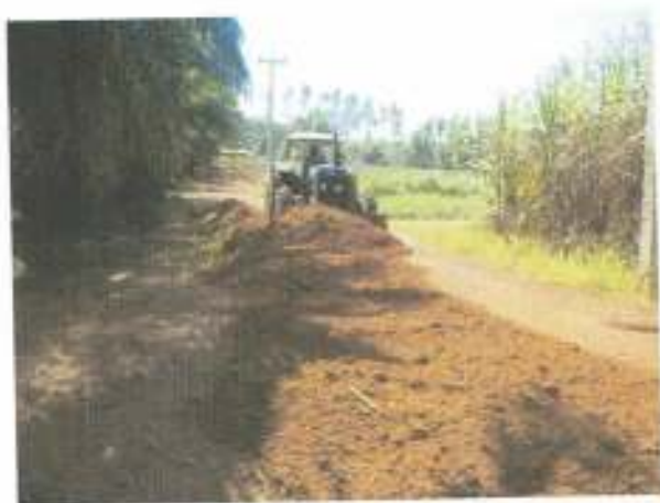
โครงการซ่อมแซมถนนลูกรังสาย ท.๖๑๖
