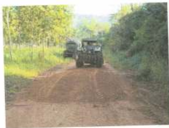
โครงการซ่อมแซมถนนลูกรังสาย ท.๓๑๐
