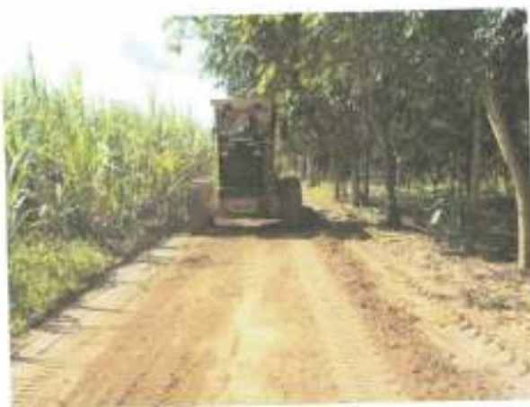
โครงการซ่อมแซมถนนลูกรังสาย ท.๓๓๕
