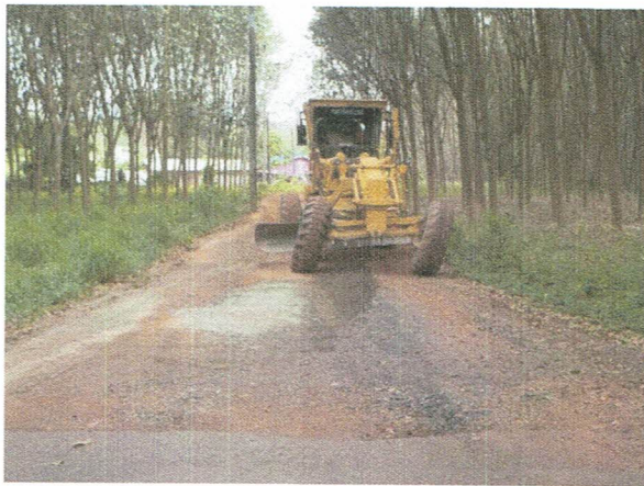
-โครงการซ่อมแซมถนนลูกรังสาย ท.๖๑๗
