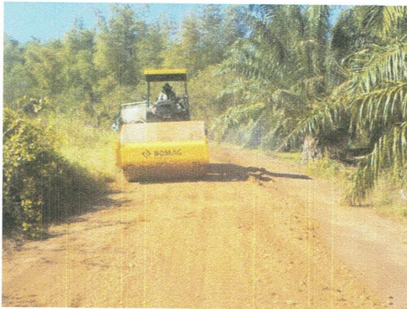
-โครงการซ่อมแซมถนนลูกรังสาย ท.๓๐๖
