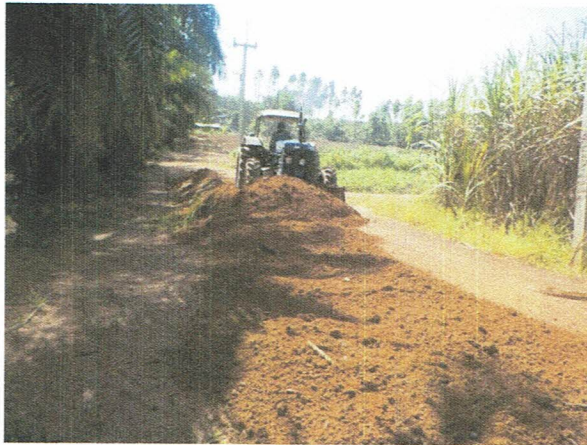
-โครงการซ่อมแซมถนนลูกรังสาย ท.๖๑๖
