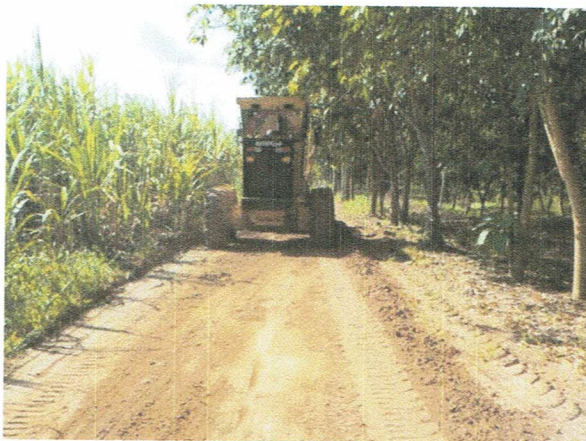
-โครงการซ่อมแซมถนนลูกรังสาย ท.๓๑๕
